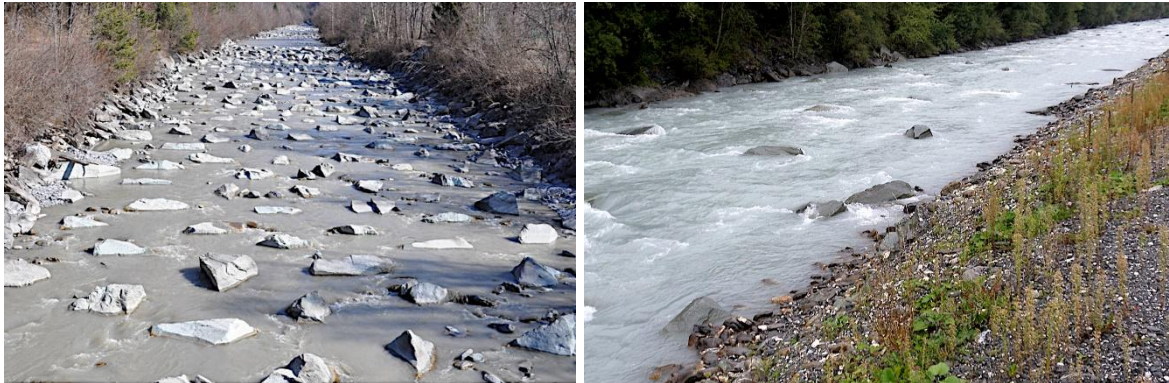
Abbildung 8: Unstrukturierte Blockrampe an der Landquart (links bei ca. 0,28 m 3 /s, rechts bei ca. 11 m 3 /s), Quellen: links – Tamagni et al. 2017, rechts – BAW/IWB
