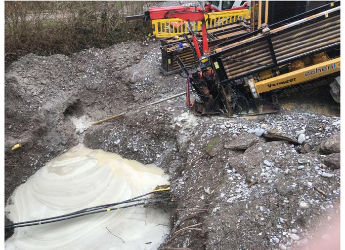
Aufgrund der Forderung nach einer redundanten Versorgung mit Trinkwasser musste eine weitere Notverbundleitung gebaut werden.
