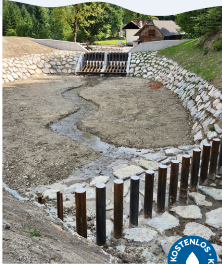
Auffangbecken für Geröll und Schwemmholtz
